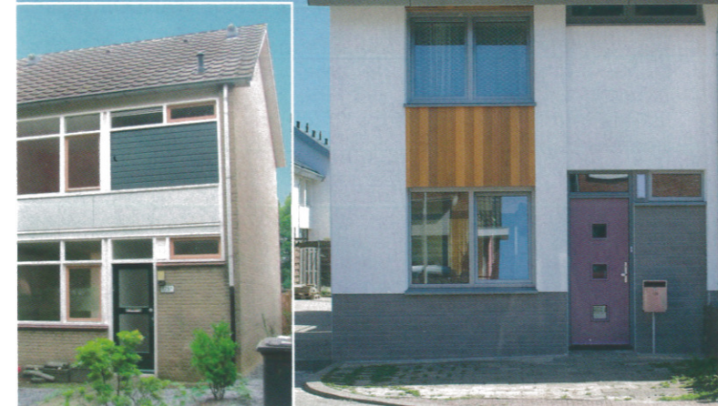
De scharnierdaken definiëren de architectuur van de wijk met hun krachtig uitstekende punten en strakke randafwerking. Bovendien verwijzen ze met hun geïntegreerde zonnecellen ook naar het energiezuinige karakter van de wijk. Het contrast met de oude situatie is groot (foto: Philip Driessen)
